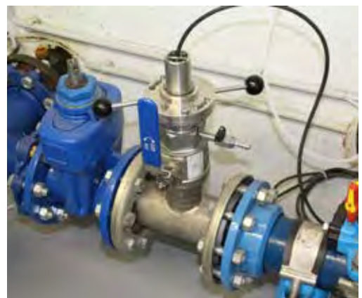
Montage de la Turbimax CUS52D sur conduite. Photo prise à Fislis.
