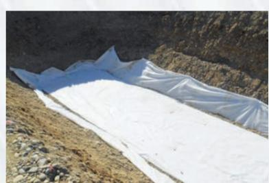
La tranchée drainante à fort coefficient de perméabilité et se gorgeant en eau très rapidement permet ainsi de diffuser le volume stocké sur **l'ensemble de la surface de contact** du substratum en place. La **surface d'infiltration** correspond donc bien à la **largeur et longueur du fond de fouille** de pose du réservoir.
