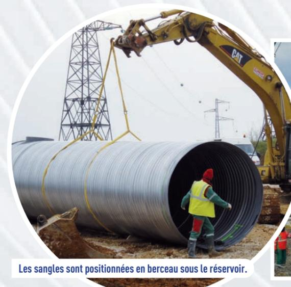
Les sangles sont positionnées en berceau sous le réservoir.
