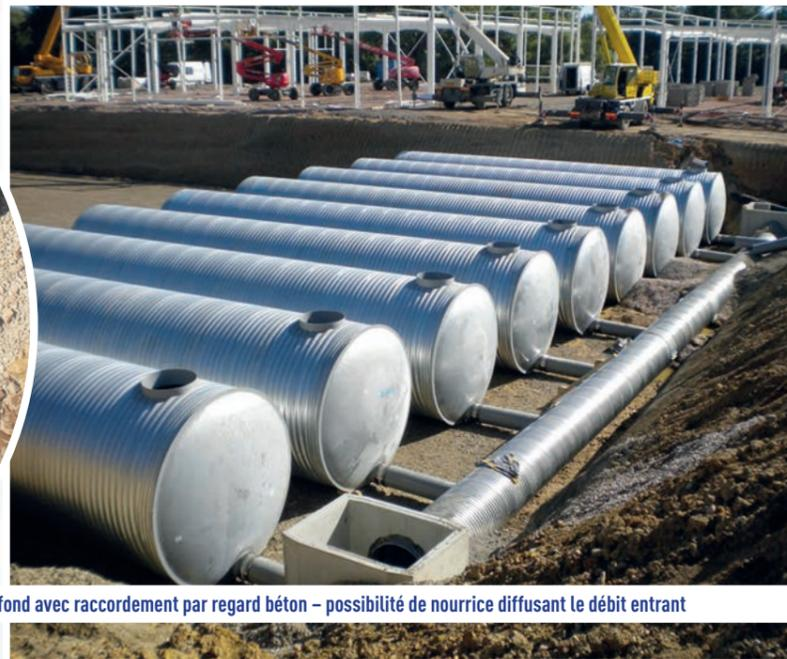
Piquages sur fond avec raccordement par regard béton - possibilité de nourrice diffusant le débit entrant
