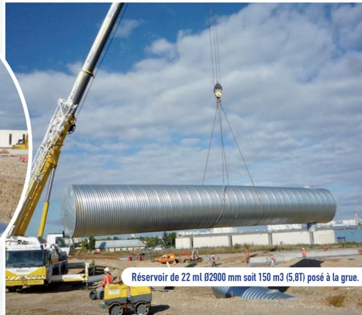
Réservoir de 22 ml Ø2900 mm soit 150 m<sup>3</sup> (5,87) posé à la grue.
