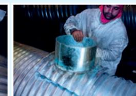
et à l'angle souhaité. Après avoir fait un trou à la disqueuse ou à la scie cloche, il suffit simplement de coller le piquage
