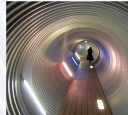
Les tuyaux SPIREL® permettent de réaliser des passages inférieurs entre 2 bâtiments. D'un **aménagement facile**, ils apportent un **design original** à la structure. Les diamètres fabriqués par Tubosider permettent les **passages piétonniers**.
