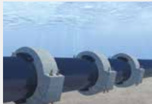
Buter les éléments de lestage d'un tube
