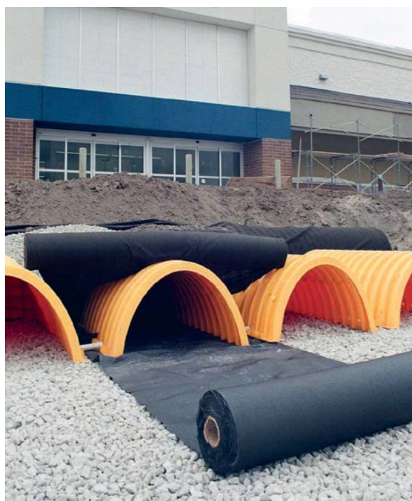
Image 11 : Géotextile tissé en bande double sous l'Isolator Row et enrobage au géotextile non-tissé pour les modèles SC-310 et SC-740
