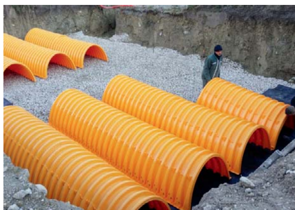
Image 12 : Géotextile tissé en double bande sous l'Isolator Row et au niveau de l'alimentation des rangées de tunnels adjacentes.
